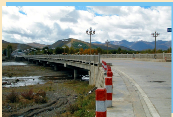
1999年重建竣工的县城城北大桥
