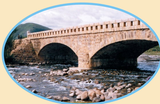
1998年水毁前的县城城北大桥
