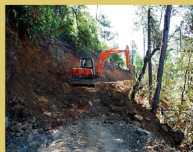
➤ 通村公路施工
