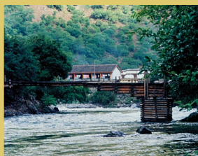
➤ 东义河上的伸臂桥
